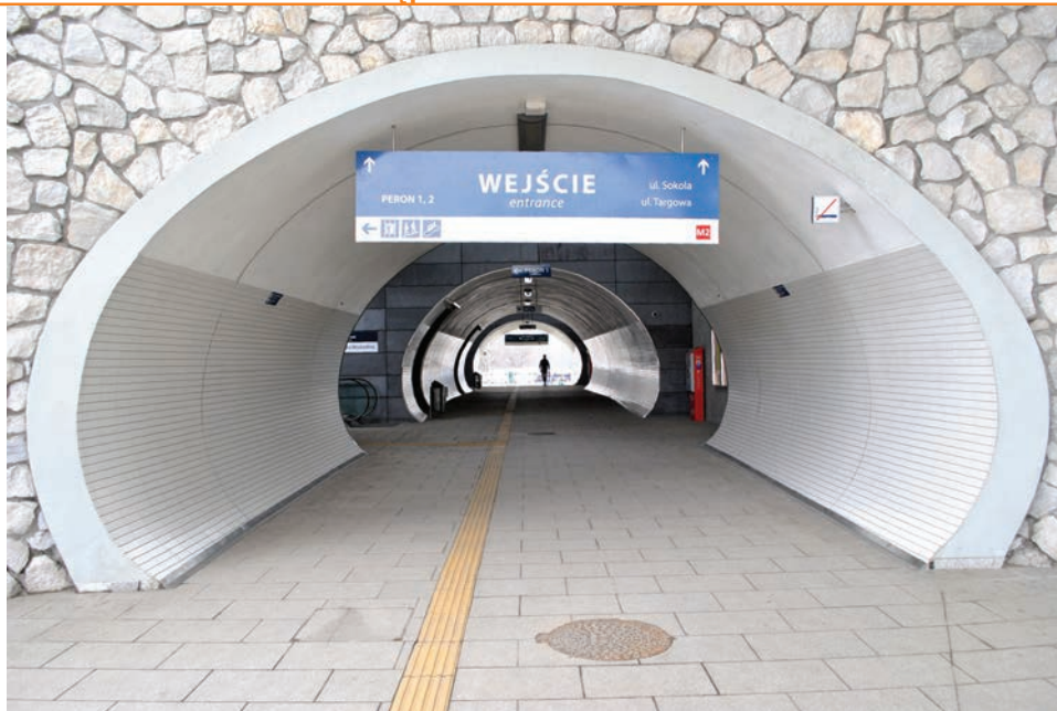
Przejście pod peronami stacji Warszawa Stadion jest wyposażone w system ścieżek dotykowych
