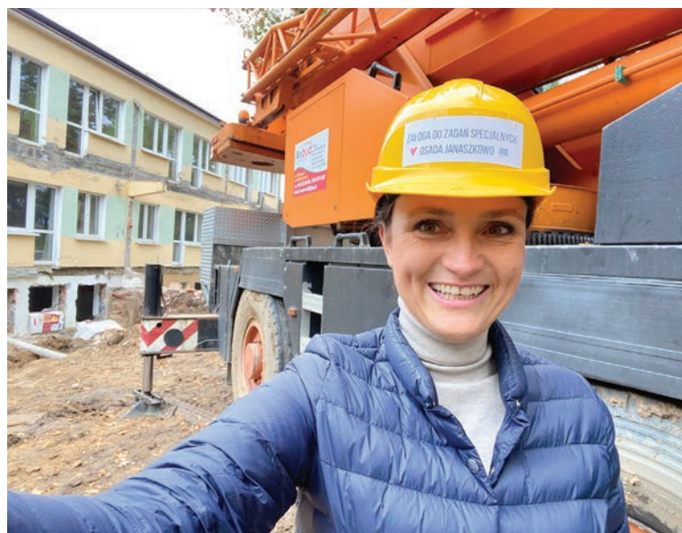
Prezes Fundacji PODAJ DALEJ na budowie Osady Janaszkowo
