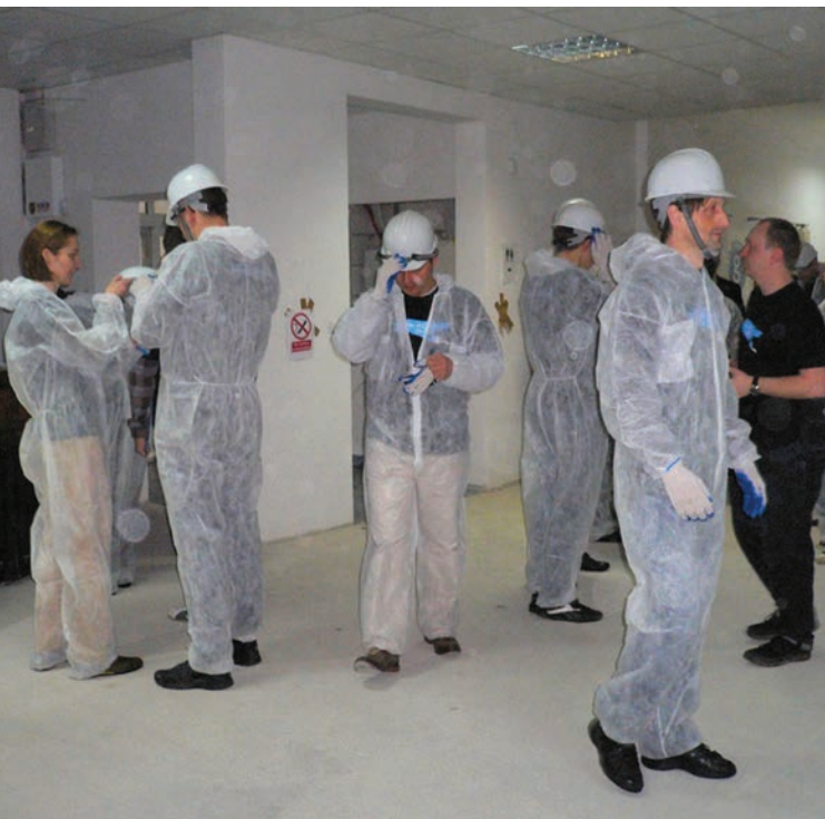
Prace budowlane i adaptacyjne
